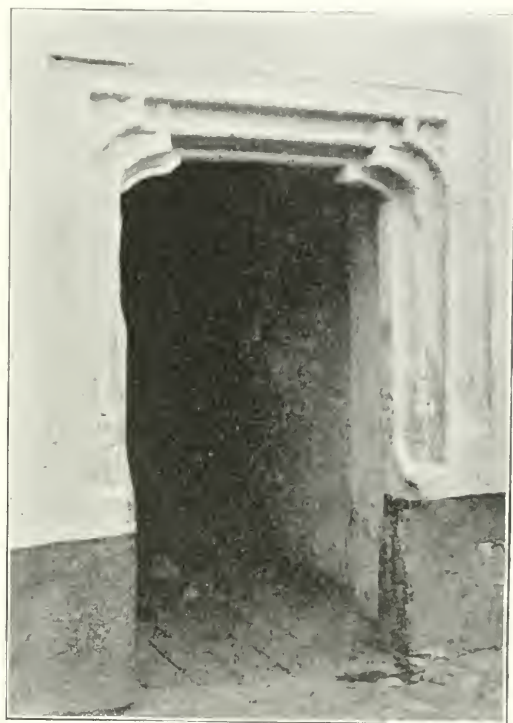
Obr. 92. Chrudim. Gotický vchod domu ve Filištinské ulici.
