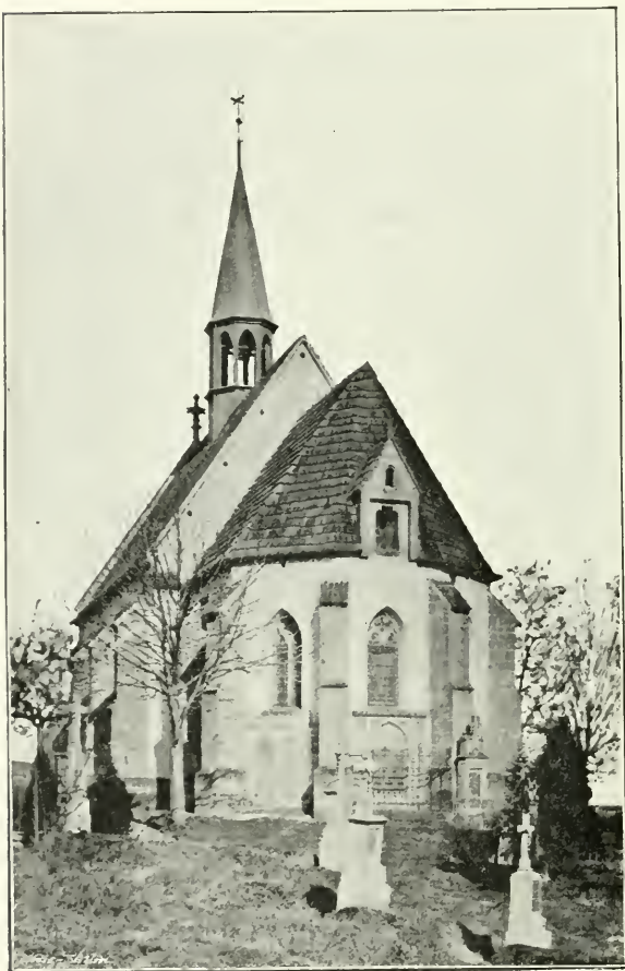
Obr. 85. Chrudim. Kostel sv. Kříže.
